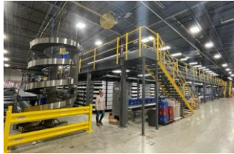
自社ECの強化に向けて、カーセル追加6基の設置工事を完了 (22年3月)
