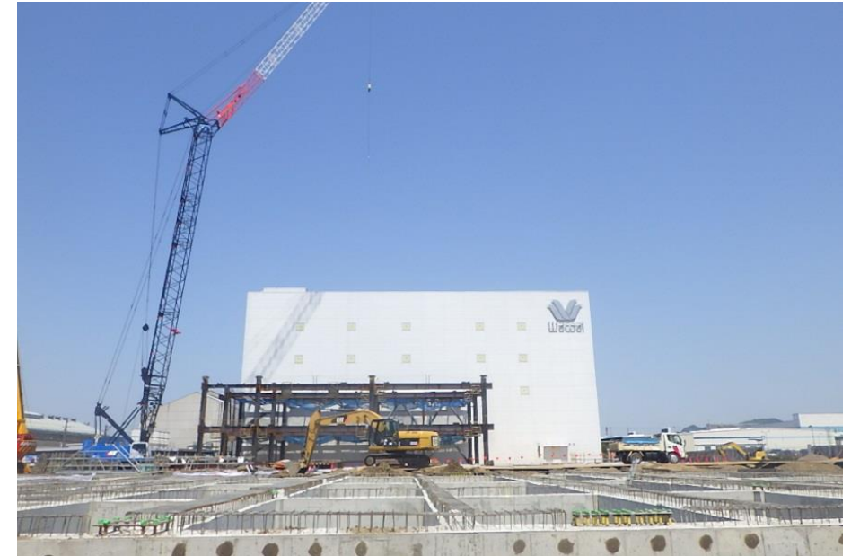
拡張工事の様子
