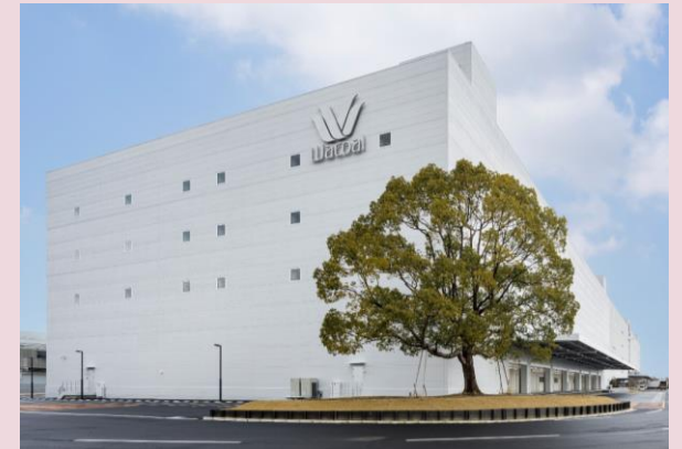
守山流通センター（増築後）
