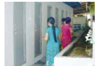
トイレブースの増設
