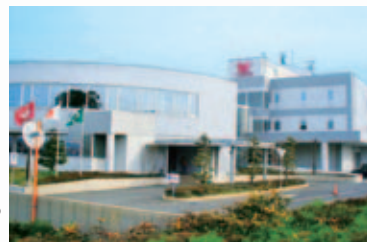
九州ワコール製造（株）の 長崎工場
